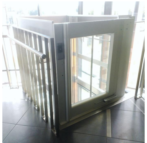
Gehäuse des offenen Aufzugs
